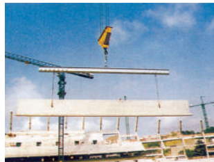
Montaje con balancín.
