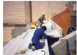
Montaje con estribos.
