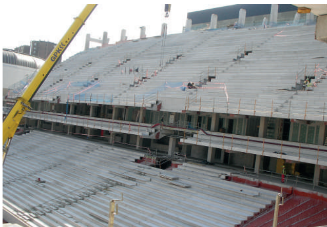
Estadio SAN MAMÉS - BILBAO (VIZCAYA).
