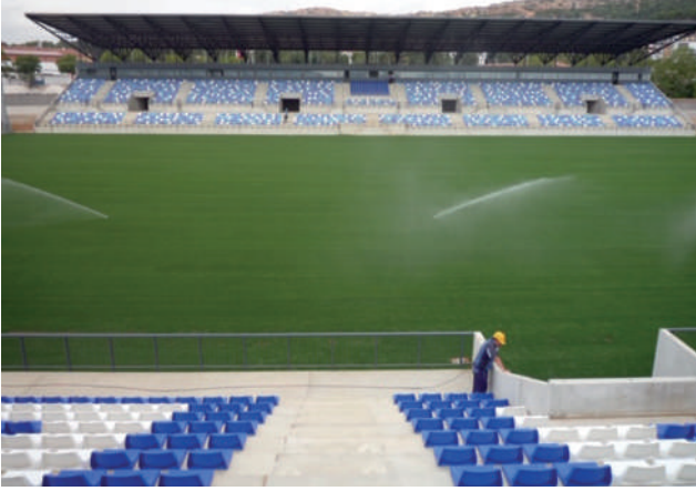
Estadio CIUDAD DE PUERTOLLANO (CIUDAD REAL).
