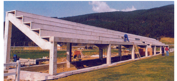
Gradas sobre estructura de hormigón prefabricado en SARON (CANTABRIA).
