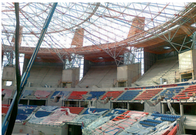
Pabellón multiusos BUESA ARENA - VITORIA (ÁLAVA).
