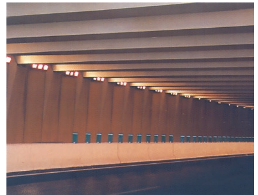
ESTRIBOS CON MÉSULA SIN CARGADERO (permite acortar la longitud de las vigas)
