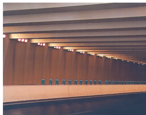
STRUCTURES AVEC CONSOLE SANS POUTRE DE PLANCHER (permet de raccourcir la longueur des poutres)
