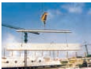
Assemblage avec poutre d'équilibre.
