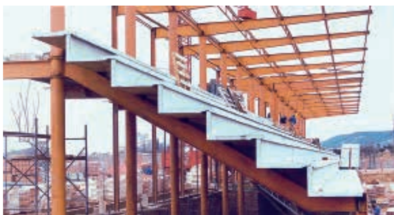
Détail des gradins sur une structure métallique (piste d'athlétisme à GUADALAJARA).
