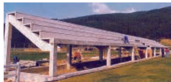
Gradins sur structure préfabriquée en béton à SARON (CANTABRIE).
