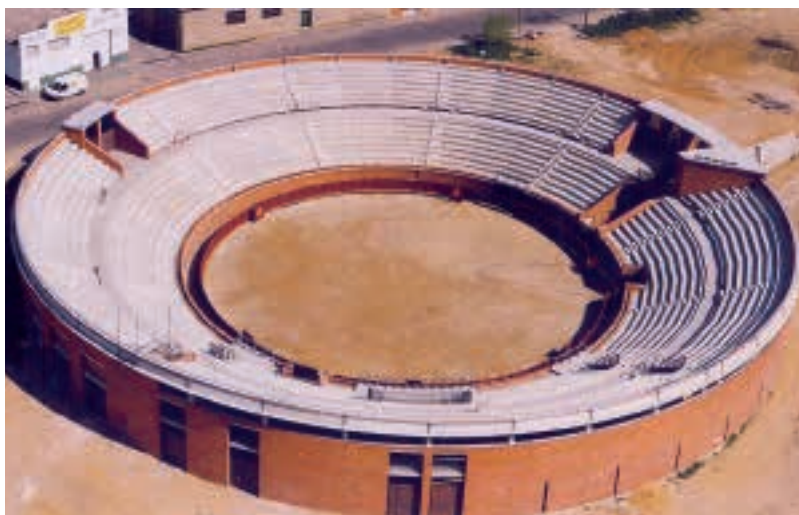
Plaza de Toros de TORDESILLAS (VALLADOLID).
