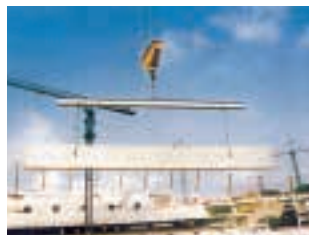
Assemblage avec poutre d'équilibre.
