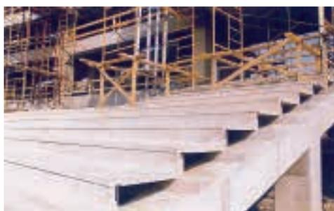
Détail de l'appui des gradins sur la poutre en béton.
