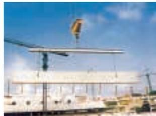
Assemblage avec poutre d'équilibre.
