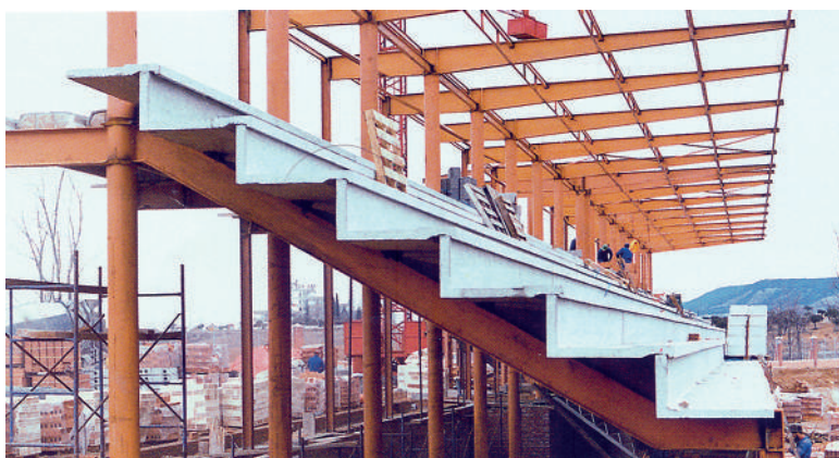
Detalle de gradas sobre estructura metálica (pista de atletismo en GUADALAJARA).
