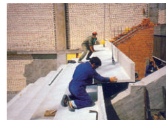
Montaje con estribos.
