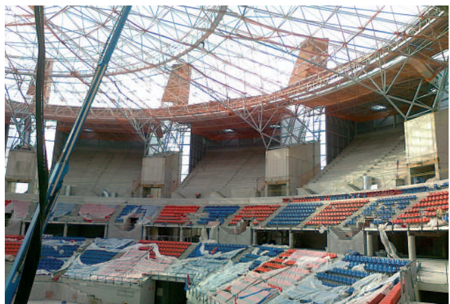
Pabellón multiusos BUESA ARENA - VITORIA (ÁLAVA).
