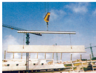
Montaje con balancín.
