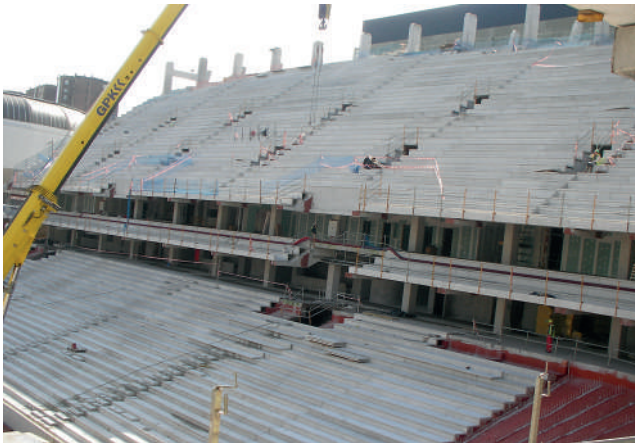
Estadio SAN MAMÉS - BILBAO (VIZCAYA).
