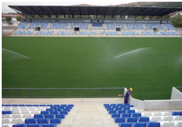
Estadio CIUDAD DE PUERTOLLANO (CIUDAD REAL).
