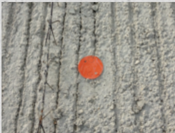
Detalle de incorporación de caja eléctrica.
